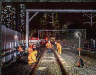
夜間の鉄道工事現場
