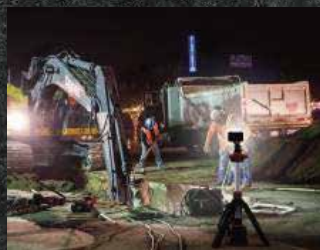
夜間の建設工事現場
