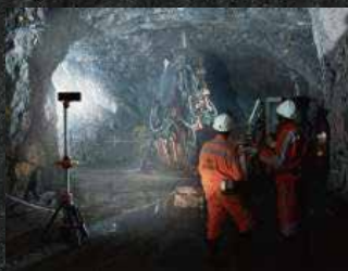
トンネル工事の照明
