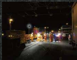
夜間の道路工事現場
