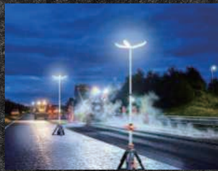
夜間の道路工事
