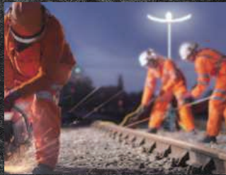
夜間の鉄道保守工事
